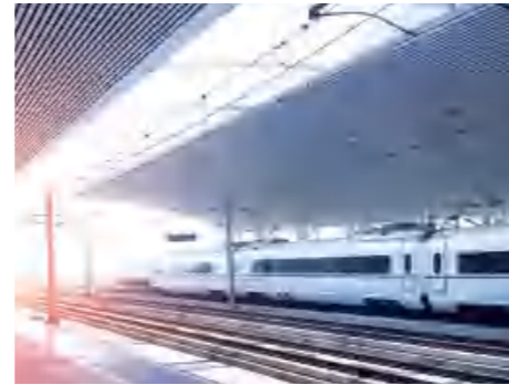
轨道交通 RAIL TRANSIT
